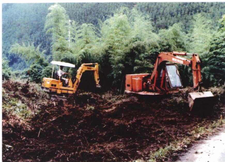
〈7月20日 重機による根切り〉
